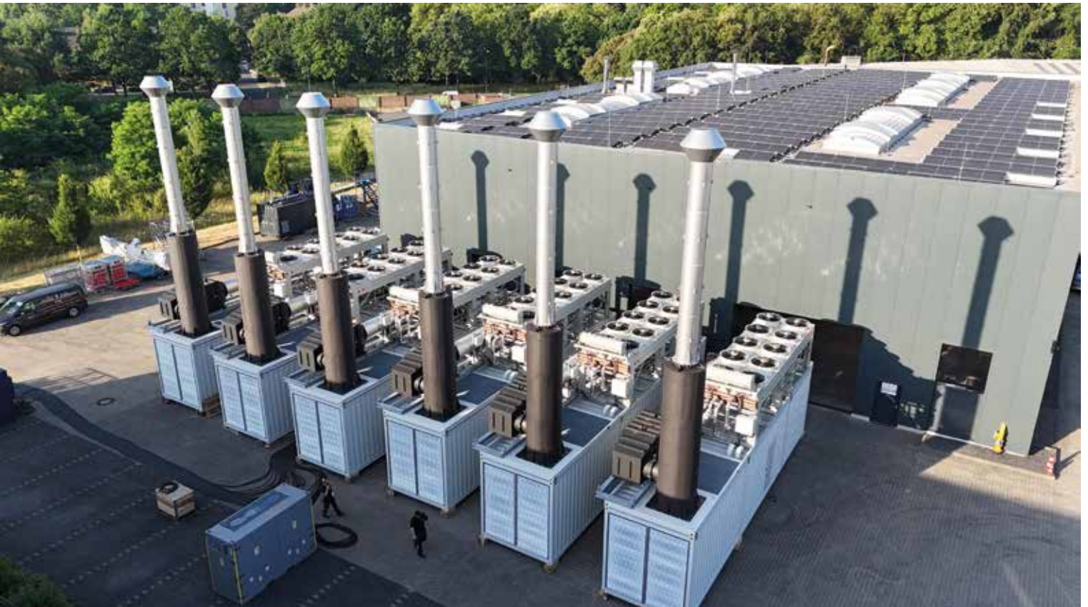
Die sechs Notstromcontainer mit je 3.250 kVA elektrischer Leistung sorgen dafür, dass bei einem Netzausfall die kritische Infrastruktur weiterversorgt wird.
